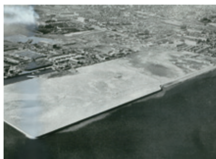
1956年 東京都砂町工事着工（自社埋立）
