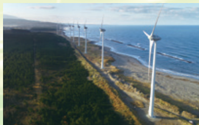
2015年 由利本荘海岸風力発電所工事着工
