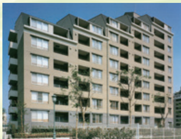
1992年 港北ニュータウンB住宅建築工事着工
