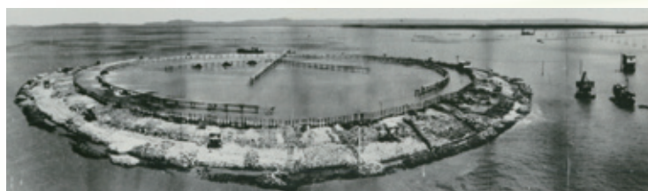
1959年 有明人工島築島工事着手
