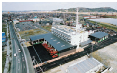
2005年 PFI石巻消防本部庁舎着工
