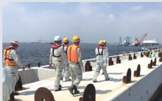
神奈川県 心頭建設工事
