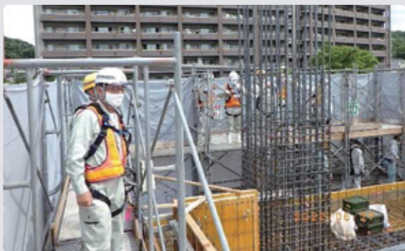
福岡県 マンション建設工事
