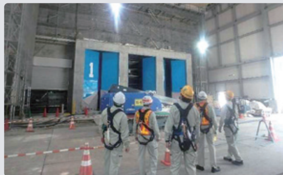
静岡県 ゴミ処理施設建設工事
