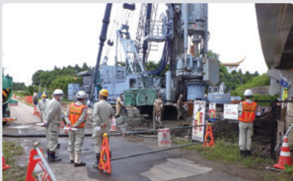
茨城県 道路橋下部工事
