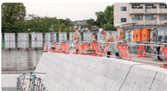
転落防止柵の確認
