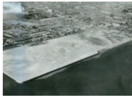
1956年 東京都砂町工事着工（自社埋立）
