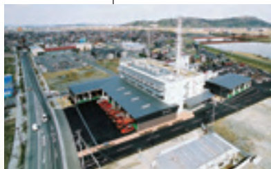
2005年 PFI石巻消防本部庁舎着工
