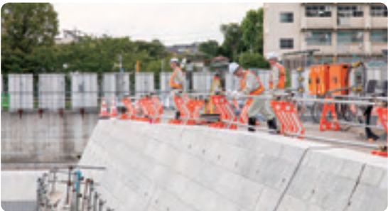
転落防止柵の確認
