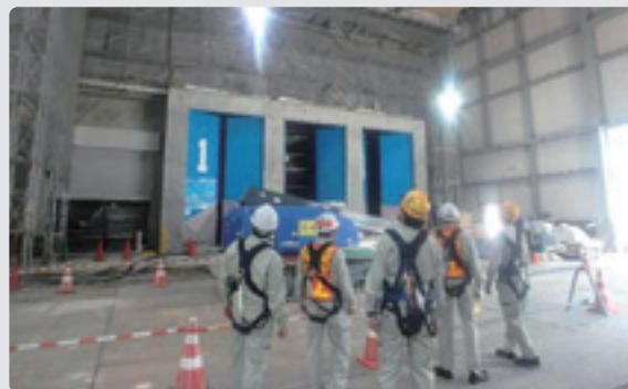
静岡県 ゴミ処理施設建設工事
