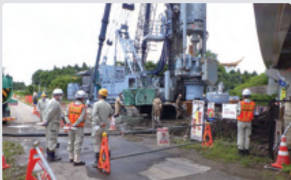
茨城県 道路橋下部工事
