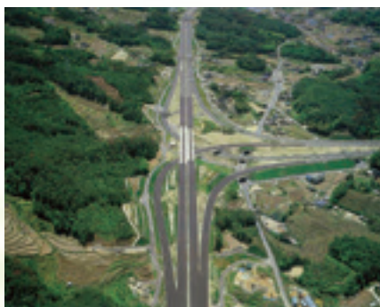
1982年 山陽自動車道広島ジャンクション工事着工
