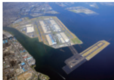
2005年 羽田空港D滑走路建設外工事着工
