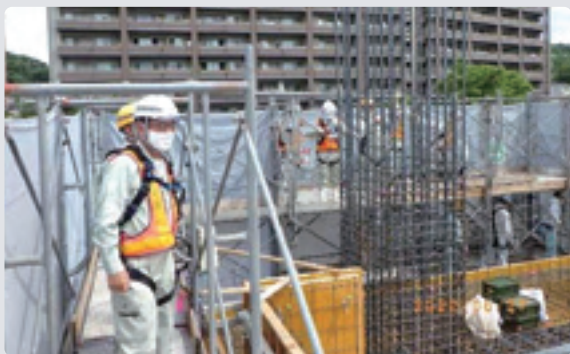
福岡県 マンション建設工事
