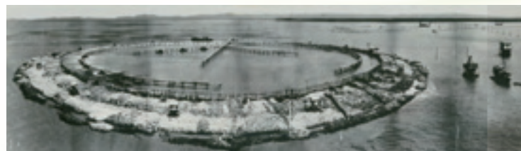
1959年 有明人工島築島工事着手
