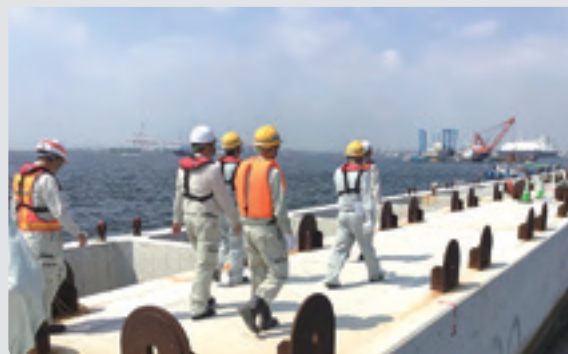
神奈川県 心頭建設工事
