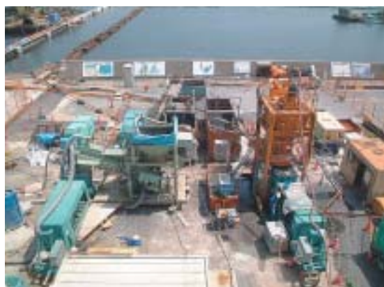
固化処理状況
