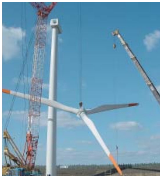
風車の設置状況
