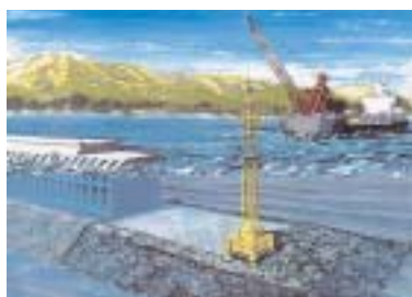
水中パイプロ式捨て石均し機
