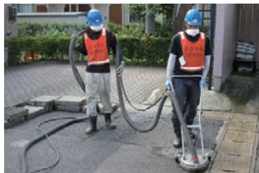
吸引式高圧水洗浄
