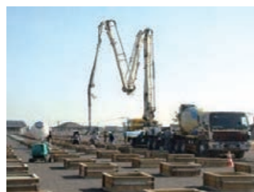
太陽光パネル架台設置
