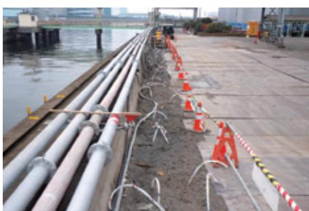
東日本大震災により被災した護岸直下地盤の補強
