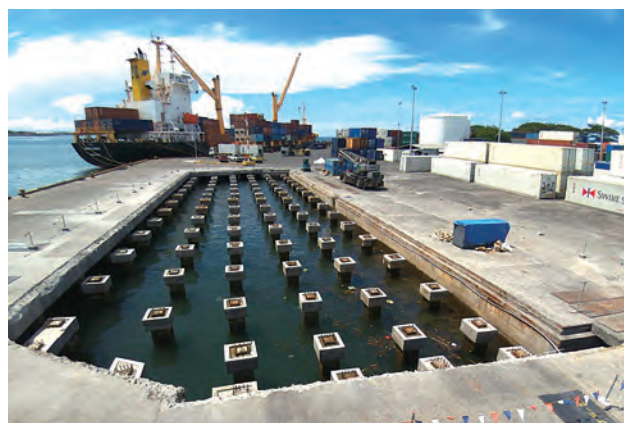
コンテナヤードのコンクリート梁およびスラブの補修
