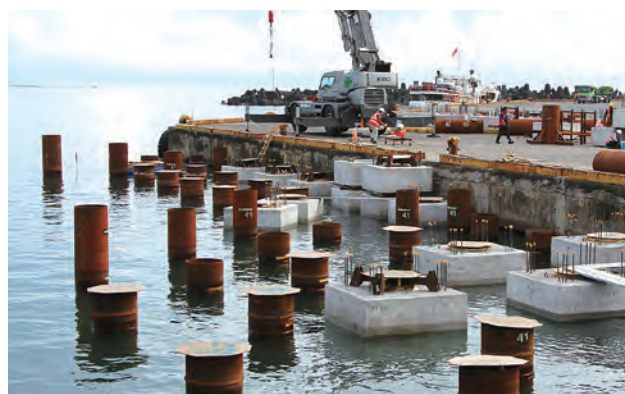
パイルヘッドの設置
