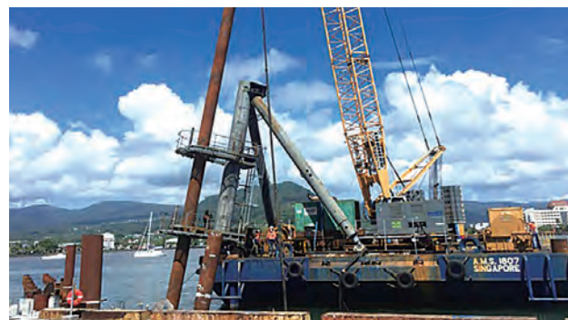
鋼管杭(斜杭)の打設
