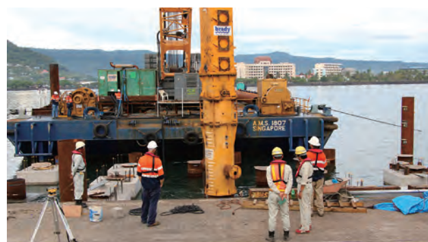
鋼管杭の打設
