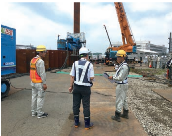
外部審査(土木現場)
