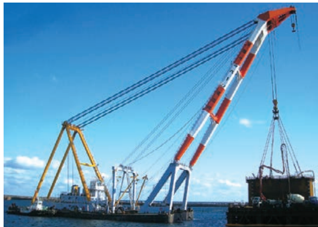
当社の施工状況
