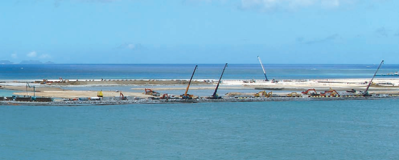
那覇空港滑走路埋立工事の施工状況
