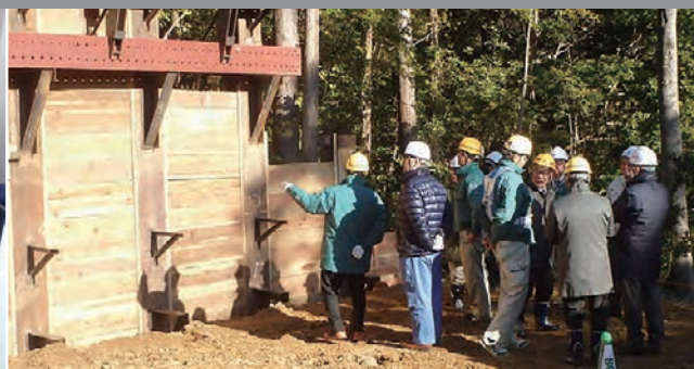
外部監査 (現場)
