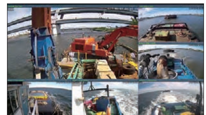
Webカメラによる状況確認
