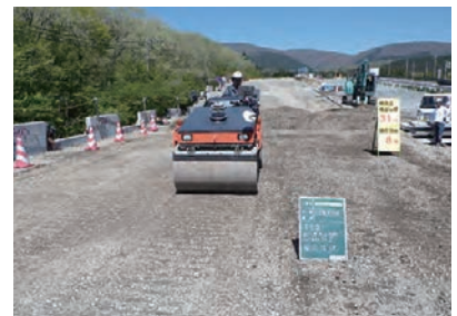
補強土壁工の裏込め施工「生産性向上チャレンジ工事」
