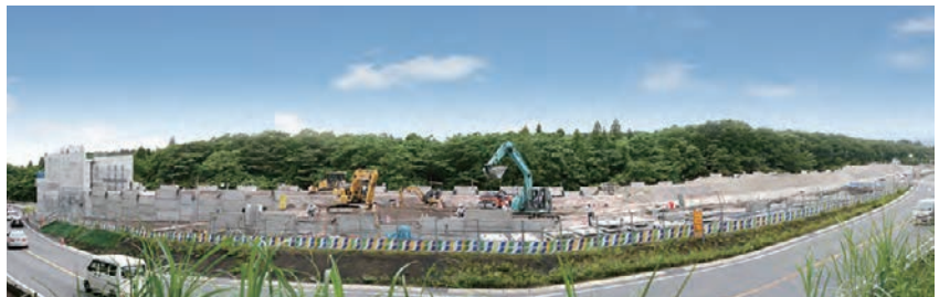
平成30年度 138号BP須走地区北道路建設工事 全景
