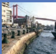
若松南海岸物揚場
