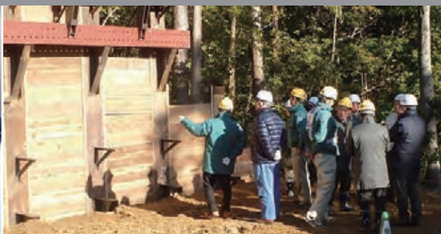
外部監査 (現場)
