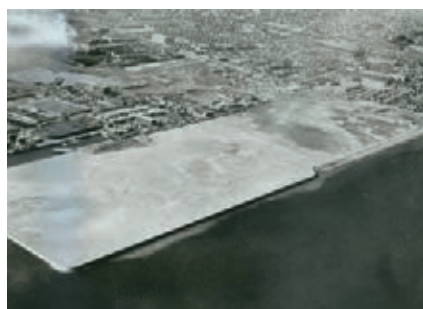
1956年 東京都砂町工事着工（自社埋立）
