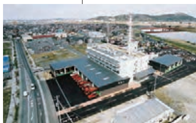
2005年 PFI石巻消防本部庁舎着工
