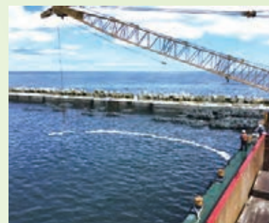
起重機船による回収
