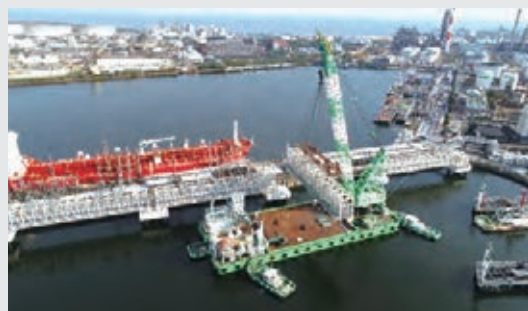
配管橋のモジュール化
