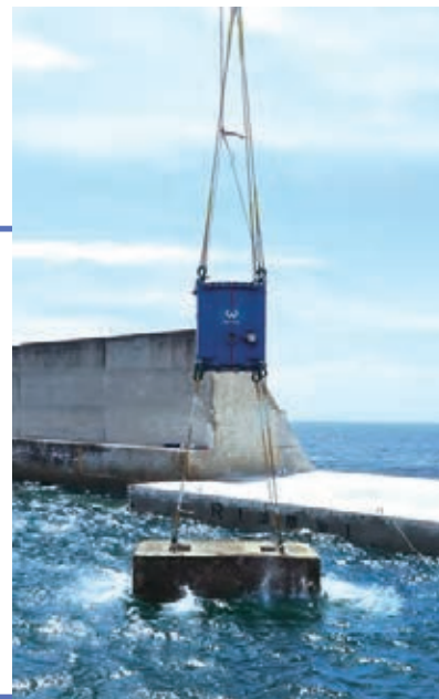
水中へのブロック据付状況
