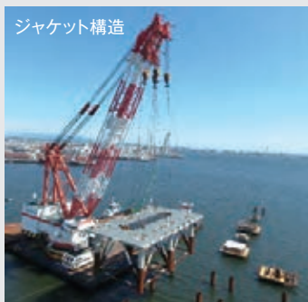
ジャケット据付状況
