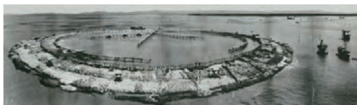
1959年 有明人工島築島工事着手
