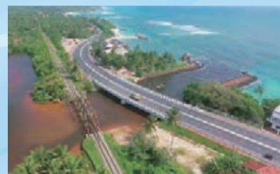
2015年 スリランカ国国道主要橋梁建設工事 パッケージ1着工
