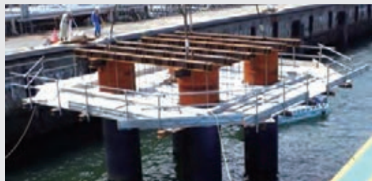
配管橋基礎-プレキャスト底型枠
