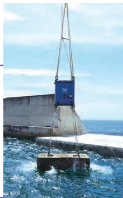
水中へのブロック据付状況
