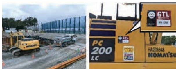
現場のGTL燃料の使用状況
