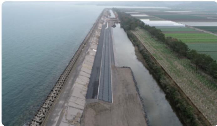
本工事は、西国東海岸保全事業の一環として堤防陸側の地盤改良工事を行うものです。地盤改良には静的締固め改良工法(SAVEコンポーザー工法)が採用され、施工しました。同時期に同工種の工事が3件発注されたため、材料や人手を確保するのが厳しく、4週8休を確保して工期内に竣工させるのに苦労しました。
