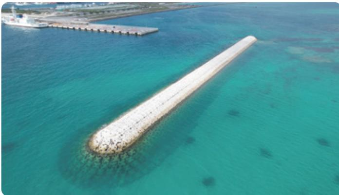
本事業は、石垣港(新港地区)に延長230mの傾斜堤の防波堤を築造するものです。本工事は、石垣港(新港地区)新港防波堤のうち100mの共通工、基礎工、被覆・根固工、測量工を施工しました。3次元データを活用するICT活用工事であり、被覆ブロック据付において3Dリアルタイムソナーを使用し、工事完了後にはマルチビームおよびUAVを用いた3次元測量を行いました。
