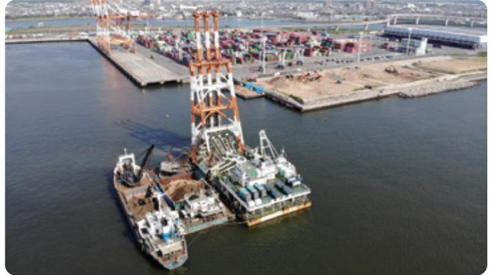
本事業は、四日市港霞ヶ浦地区のコンテナ貨物量の増加および岸壁を使用する船舶の大型化に対応するために、岸壁を300m延伸するものです。本工事は、岸壁延伸に伴いサンドコンパクションパイル工法による海上地盤改良工事を施工しました。サンドコンパクション工法は、水はけのよい砂を杭状にした「砂杭」を軟弱地盤に打設し、地盤中の水を滲み出させることで地盤を改良するものです。
