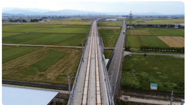
本工事は、北陸新幹線の金沢から敦賀までの延伸工事のうち、福井県坂井市において延長2,569mの高架橋を施工しました。現場周辺は、全線に渡り水田地帯に集落が点在しており、工事場所を農道や用排水路が多数横断していたため、農耕地に対して悪影響を及ぼさないよう細心の注意を払いながら、作業を行いました。
