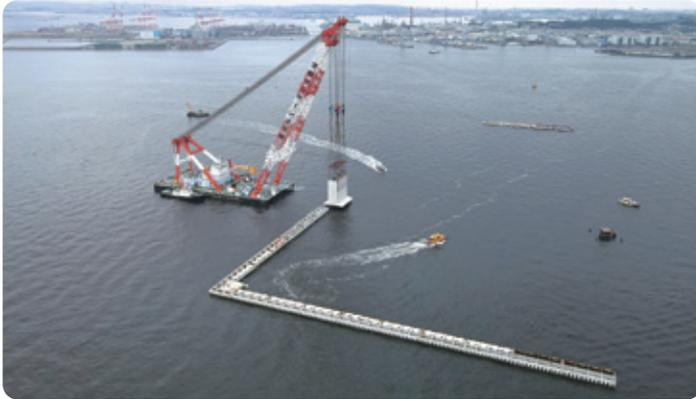
本事業は、コンテナ船の大型化および貨物量の増加に対応するため、横浜港本牧ふ頭の沖合に大水深・高規格コンテナターミナルならびに高度な流通加工機能を有するロジスティック施設を一体的に配置した物流拠点である新本牧ふ頭を形成するものです。本工事は、施工場所が既設護岸から離れた海上で、最大5件の工事が隣接して作業する状況でしたが、綿密な作業調整を行い竣工することができました。
