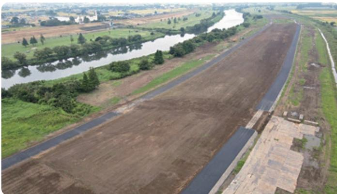
本事業は、荒川流域の洪水防止対策として整備される荒川第二・三調節池事業であり、整備期間は2018年から~2030年までが計画されています。本工事は、荒川第二調節池の圍繞堤築造に伴う基盤盛土、管理用道路造成を施工し、国土交通省が推進する、建設現場にICTを活用し生産性アップをめざす取り組みのi-Constructionを導入しました。
