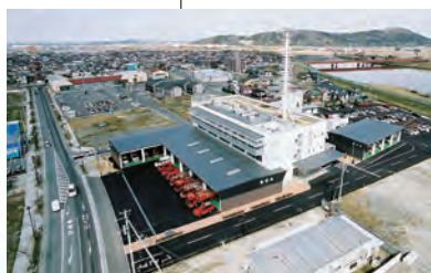
2005年 PFI石巻消防本部庁舎着工
