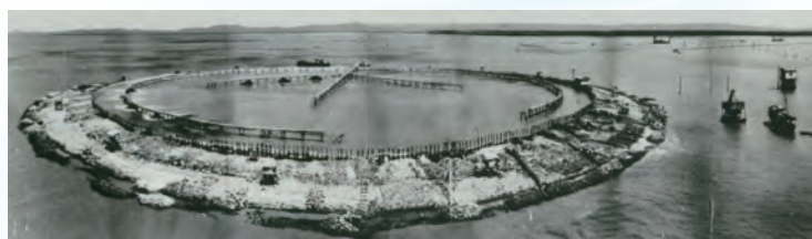
1959年 有明人工島築島工事着手
