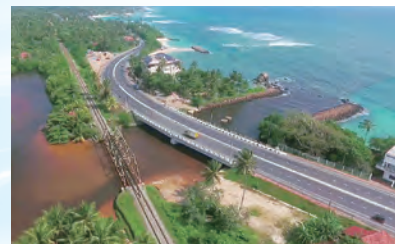
2015年 スリランカ国国道主要橋梁建設工事 パッケージ1着工
