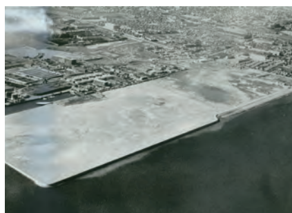
1956年 東京都砂町工事着工（自社埋立）
