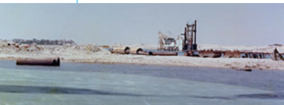
1976年 スエズ浚渫工事着工
