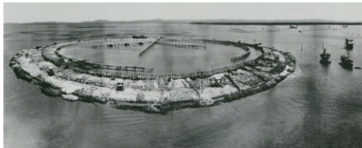
1959年 有明人工島築島工事着手
