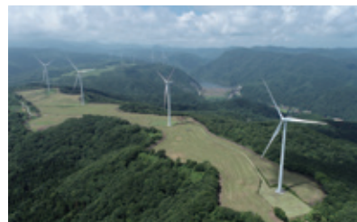
2024年 JRE宮城加美町ウインドファーム 建設工事
