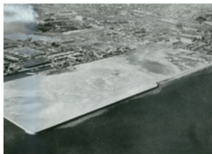
1956年 東京都砂町工事着工（自社埋立）
