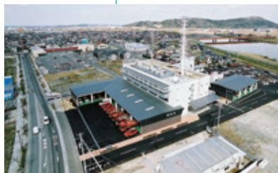
2005年 PFI石巻消防本部庁舎着工
