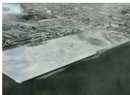
1956年 東京都砂町工事着工（自社埋立）
