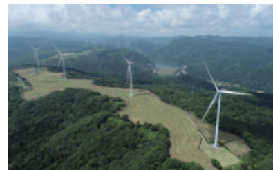
2024年 JRE宮城加美町ウインドファーム 建設工事
