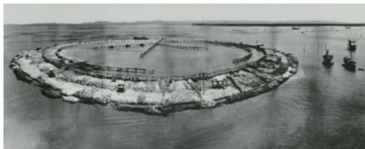
1959年 有明人工島築島工事着手
