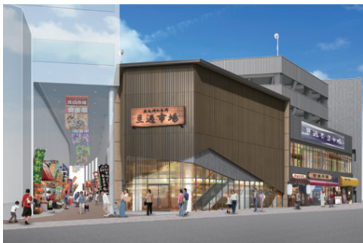
整備後の旦過市場
