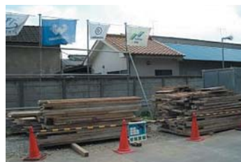
型枠端材集積(東京支店)
