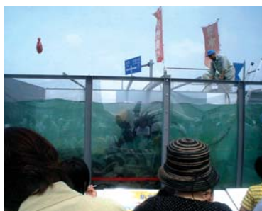
特設水槽内の潜水夫石均しの実演
