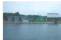
脱水処理プラント全景
