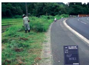
施工現場周辺の草刈り(北陸)
