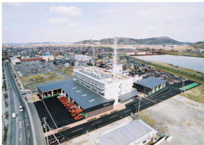
消防本部庁舎全景
