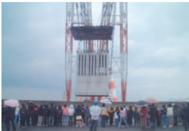
ケージ吊り上げ作業
