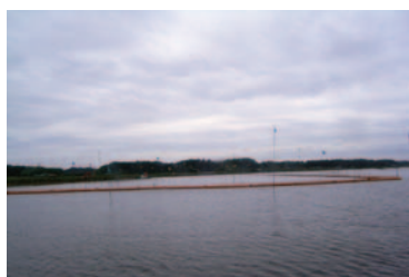
汚濁防止膜設置
