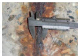
鉄筋径の測定
