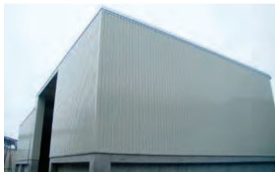
木屑貯蔵倉庫
