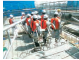
港湾工事見学会(新潟)
