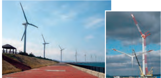
響灘風力発電施設の建設
