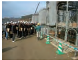
橋梁工事見学会(徳島)
