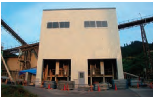
木屑破砕施設
