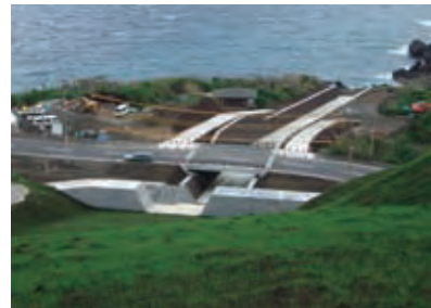
床固工・護岸工
