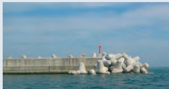
80t型消波ブロックで保護された突堤
