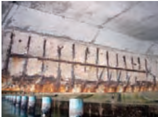
栈橋下面・梁（38年経過）
