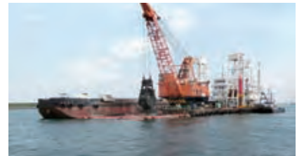
海上浚渫工事
