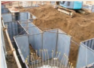
残置型枠の使用
