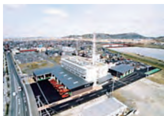
石巻広域行政事務組合 消防本部庁舎
