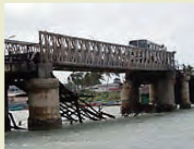
1990年に爆破されたため、組立て式仮橋で対応していた旧マナー橋
