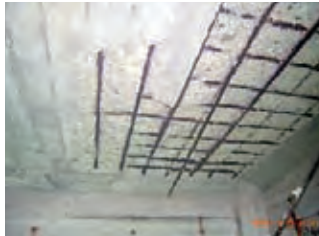
栈橋下面・スラブ（39年経過）
