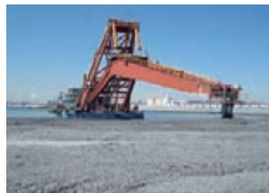
管中混合固化処理土の打設
