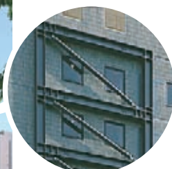
油圧式制震ブレース
