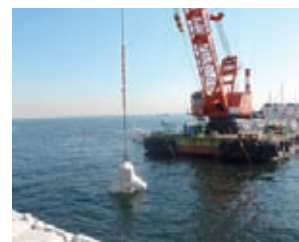
消波ブロック据付け
