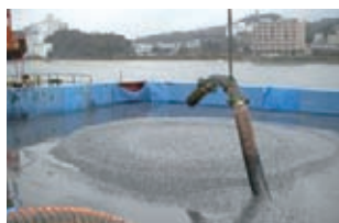
カルシア改質土の打設
