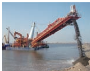
建設発生土の揚土
