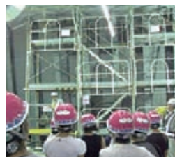
トンネル工事の現場見学会（福岡）
