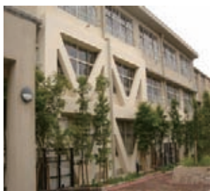
小学校の耐震補強
