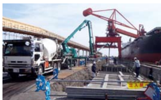
コンクリート打設(5・6号地区)
