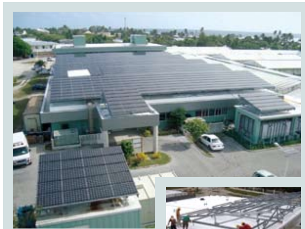
システムを設置したマジェロ病院
