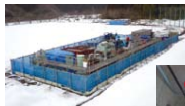
試験設備全景
