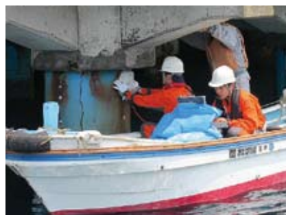
測定状況（海上）
