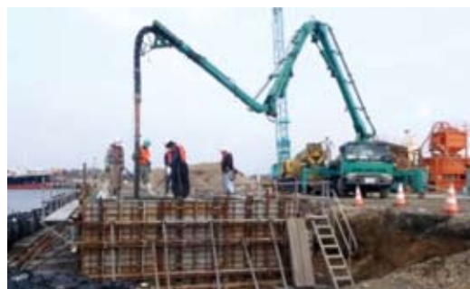
コンクリート打設(藤原地区)
