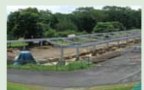
システムを設置する駐車場
