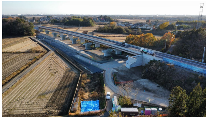
R3圏央道上郷高架橋下部その1工事
