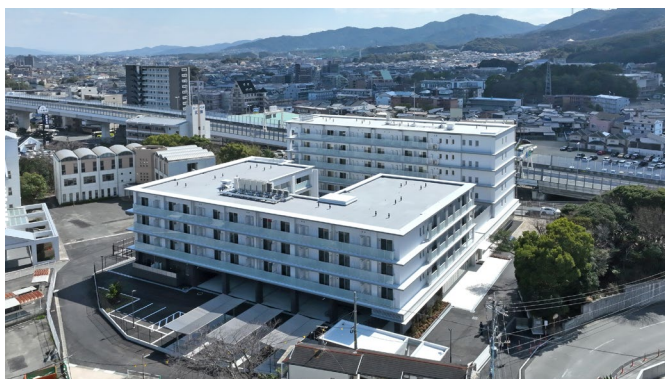
福岡大学自修寮（仮称）新築工事
