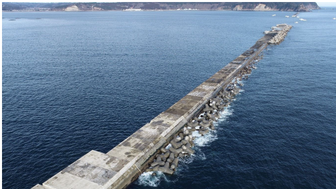
久慈港湾口地区防波堤（北堤）消波ブロック据付工事
