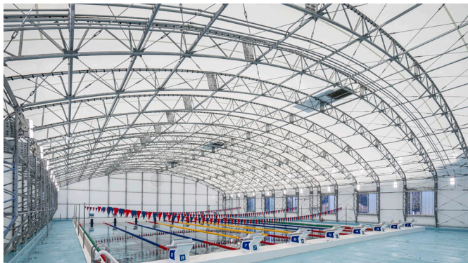
扇島プール新築工事
