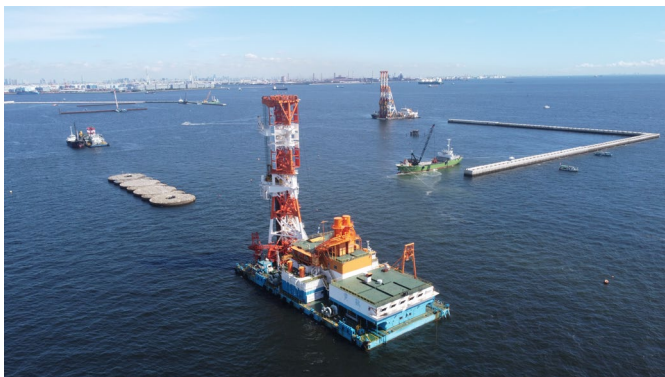
令和5年度横浜港新本牧地区護岸（防波）他地盤改良工事
