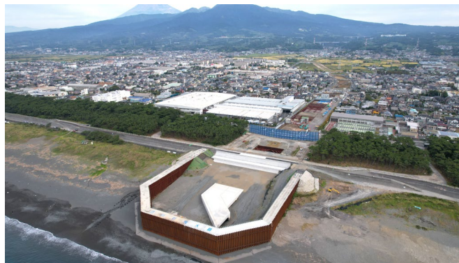
令和元年度富士海岸沼川新放水路建設工事
