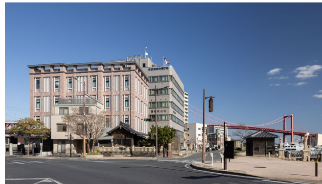
第一港運株式会社社屋建替工事
