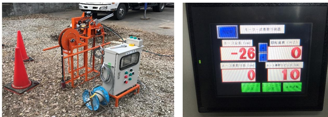
注入ホース巻き上げ装置の計測試験状況とモニター画面
