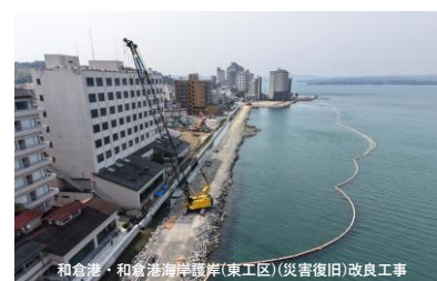
和倉港・和倉港海岸護岸(東工区)(災害復旧)改良工事
