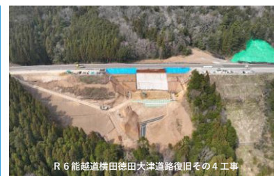
R 6 能越道横田徳田大津道路復旧その4 工事
