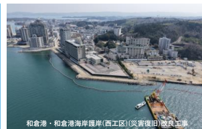
和倉港・和倉港海岸護岸(西工区)(災害復旧)改良工事
