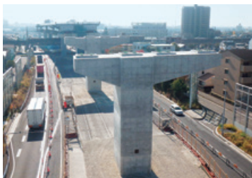
工事完成写真
