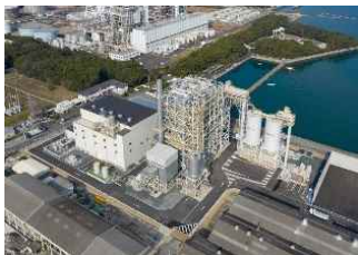
バイオマス発電所
