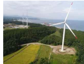
七里長浜風力発電所
