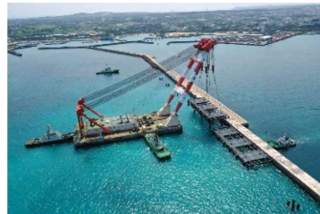
平良港(-10m)岸壁
