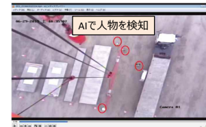
クレーンカメラAIによる作業員認知
