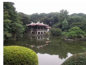
新宿御苑底泥除去工事
