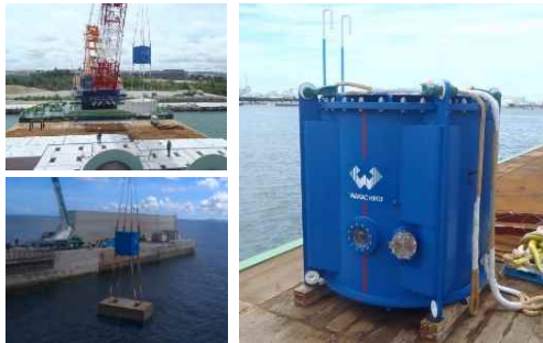
吊荷回転制御装置「水中ジャイロ」
