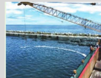
起重機船による回収
