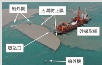
②砂採取船による方法
