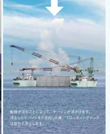
船体が沈むことによって、ケーソンが浮かびます。浮上したケーソンを引き出した後、フローティングドックは自力で浮上します。
