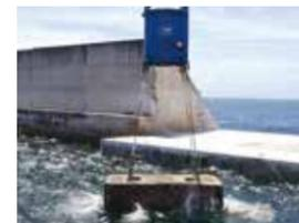
吊荷回転制御装置
