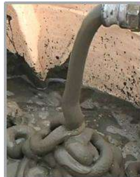
d) 注入時状況
