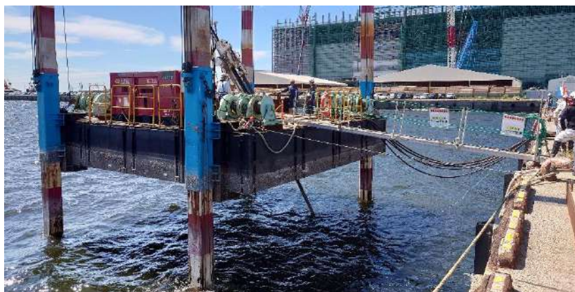
写真-5. 2. 2 川崎港における SEP 台船による捨石削孔状況
