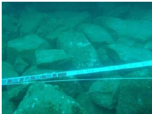
写真-2.2.1 捨石マウンド表面調査の例 1)
