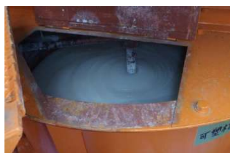
(b)可塑性材練混ぜ状況
